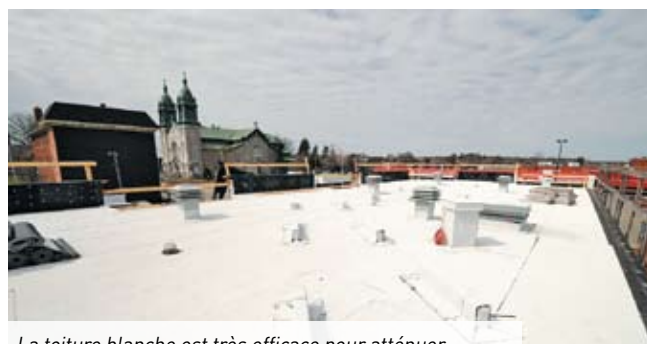
La toiture blanche est très efficace pour atténuer les îlots de chaleur urbains et limiter les dépenses de climatisation l'été. © CELINELECOMTE.COM
